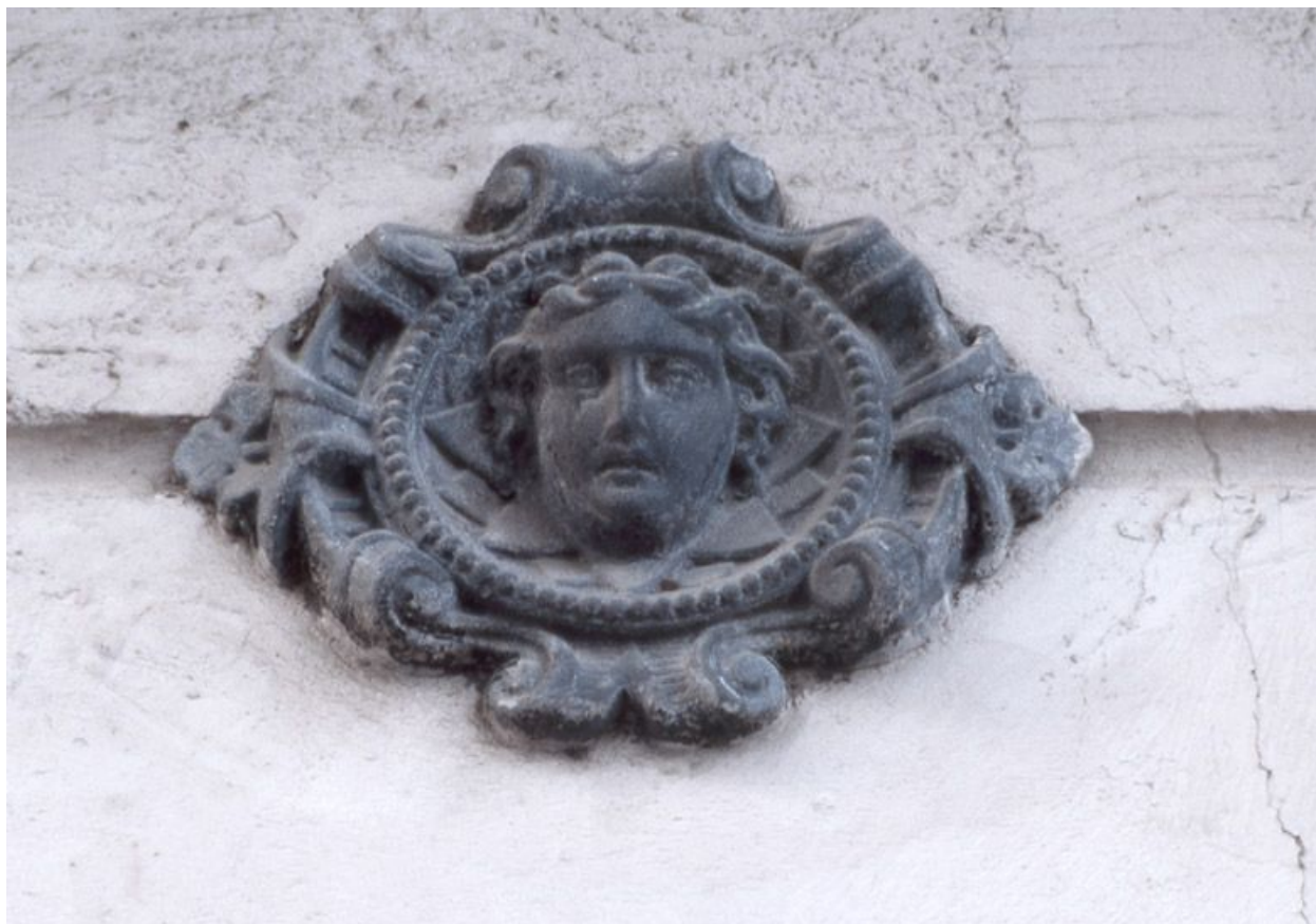
Détail de la façade du réfectoire : médaillon en fonte.
