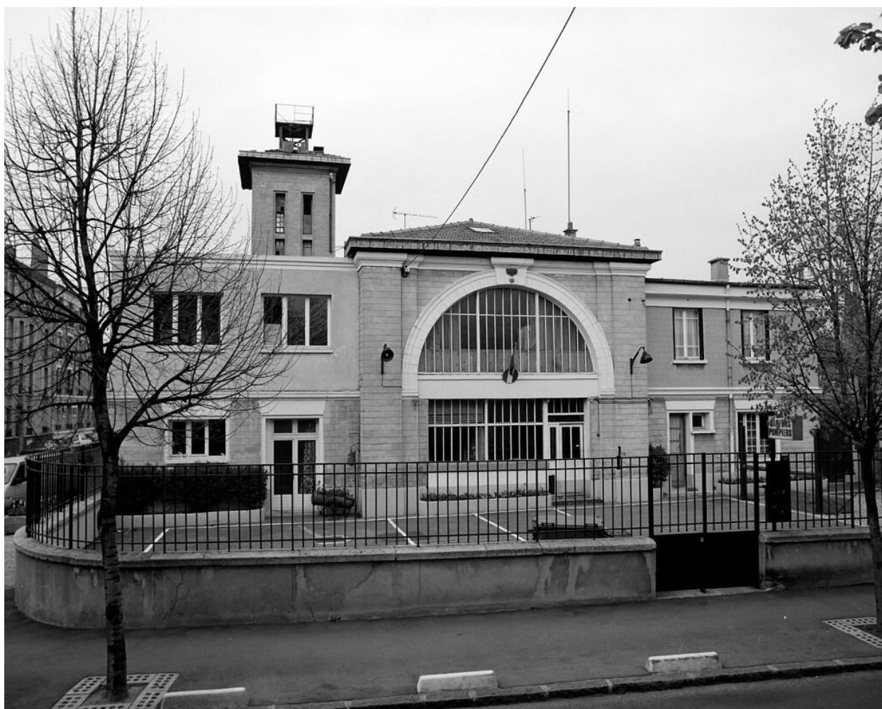
Vue d'ensemble depuis la rue de Stalingrad. Gymnase, Remise (Gymnase Municipal, Remise de Pompiers)
