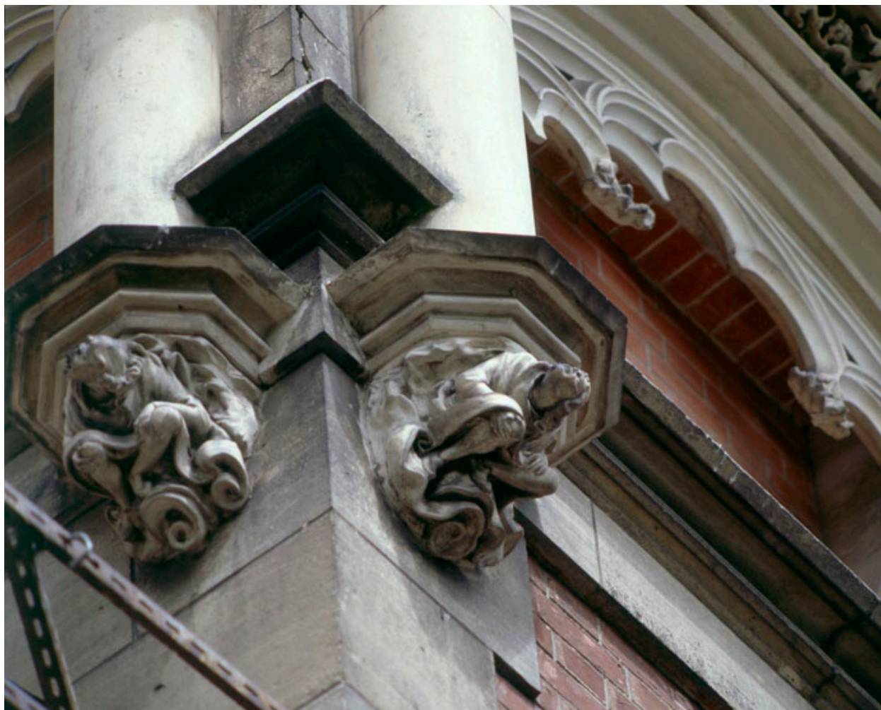
Composition architecturale de la partie supérieure du pavillon central, façade sur le lac : détail de deux culots sculptés ornés de personnages.
