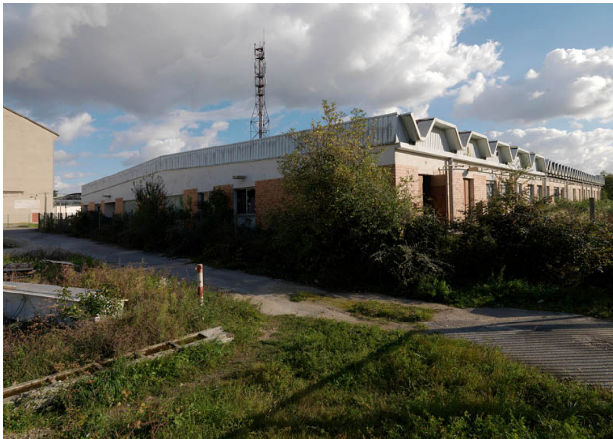
Vue extérieure de l'atelier des circuits imprimés (1979-1981), couvert de sheds en coques "M" autoportantes.
