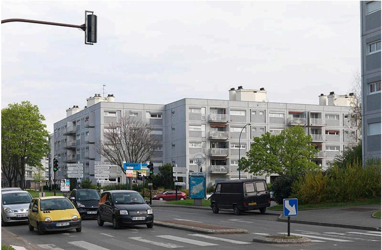
L'avenue Saint-Marc bordée d'immeubles de Jean Ginsberg. Les deux barres R+4 reprennent la composition générale de l'ensemble : panneaux préfabriqués assemblés en différentes combinaisons. On note des édicules sur les toits terrasse constitués des machineries d'ascenseurs.
