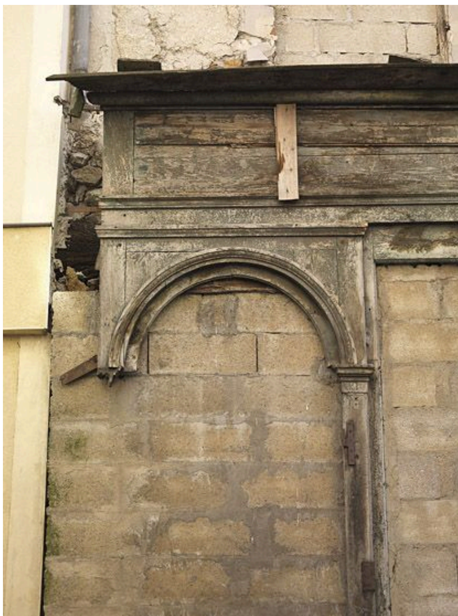
Maison 7 rue du Tan : détail de la devanture (19e siècle), avant rénovation.
