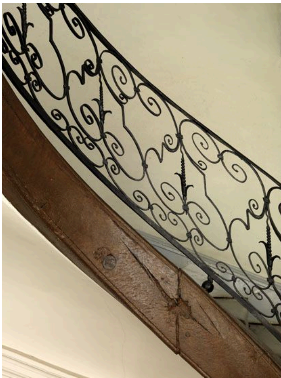
Détail des balustres.
