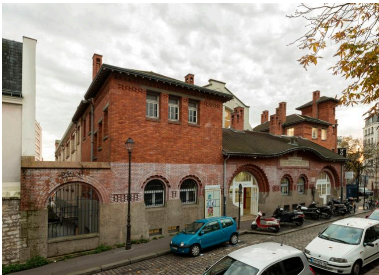
Vue générale de la piscine et des bains-douches de la Butte-aux-Cailles, place Paul Verlaine (Paris, 13e).
