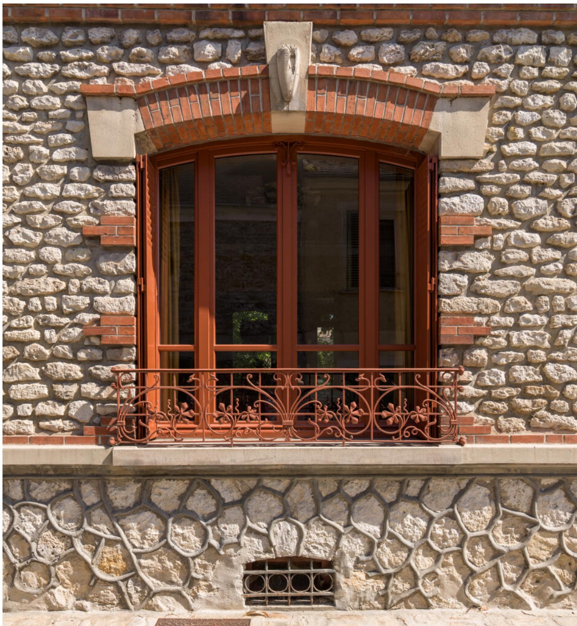
Fenêtre du rez-de-chaussée.
