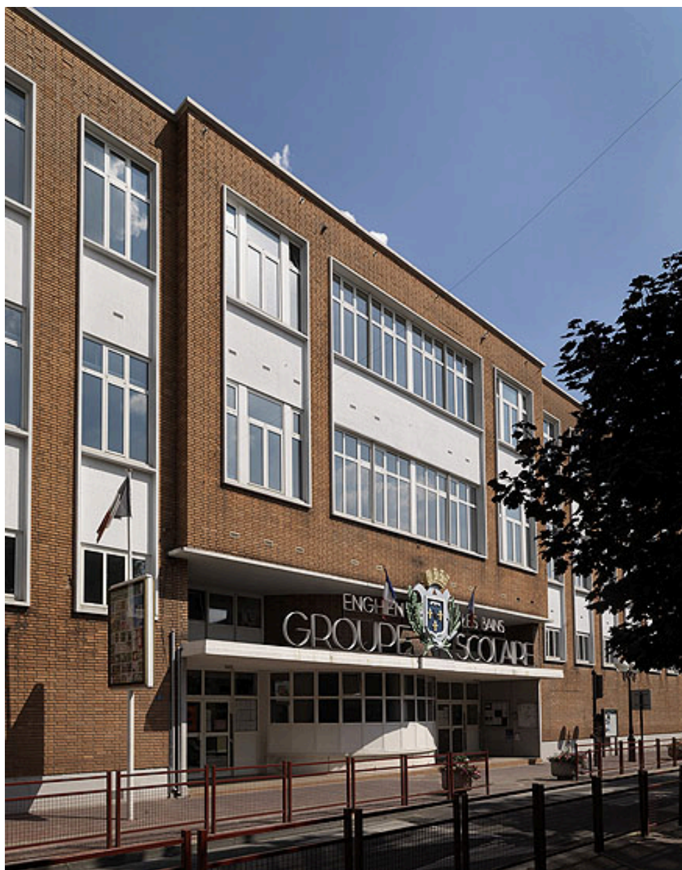
Vue de la partie centrale du bâtiment donnant sur le boulevard d'Ormesson.
