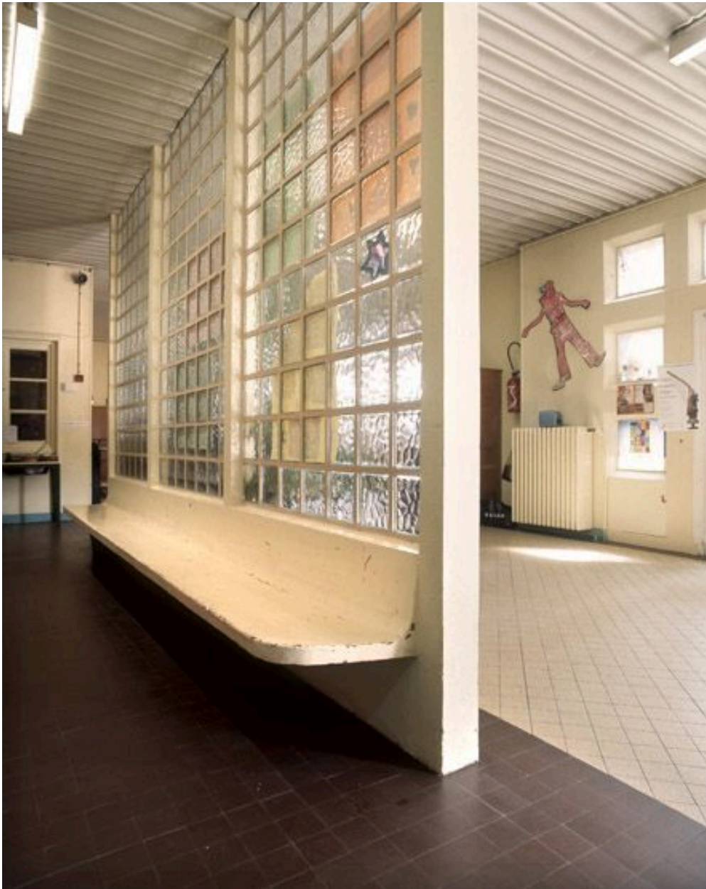
Groupe scolaire Joliot-Curie, rue Irène Joliot-Curie. Julien Heulot (architecte communal). Vue intérieure du hall, banc en béton moulé le long d'une cloison en pavés de verre.
