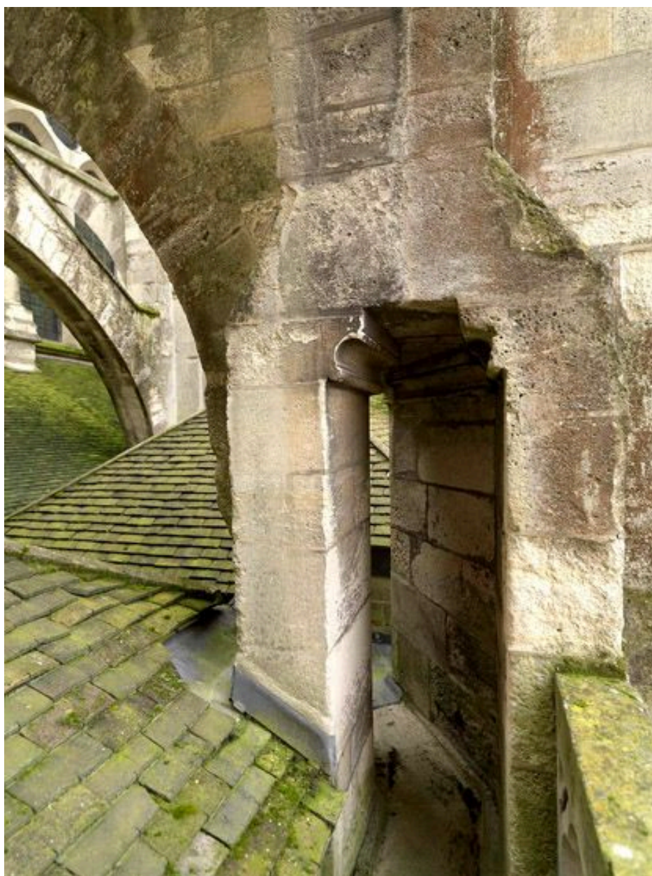
Galerie de circulation au niveau des arcs-boutants, côté nord.
