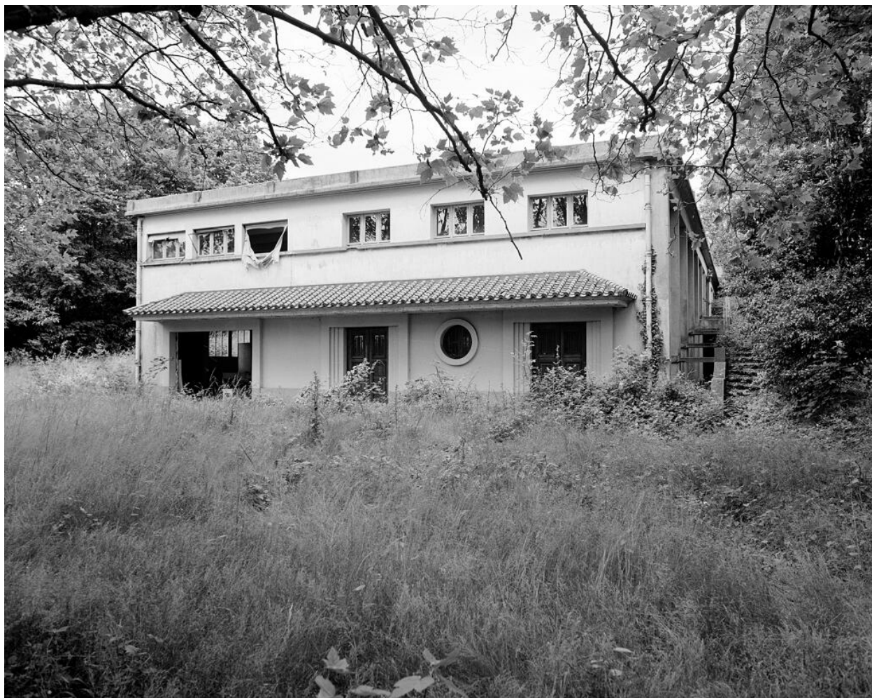
Façade Sud du gymnase. Maison de maître dite le Moulin Fidel
