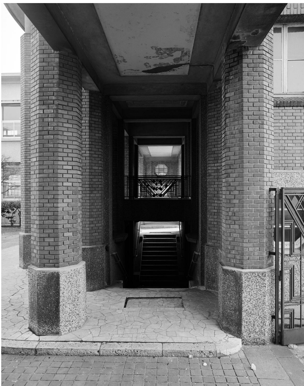
Bâtiment de la piscine : vue sous le porche d'accès (côté gauche).. groupe scolaire - collège Henri-Sellier, puis groupe scolaire - collège de la Cité Jardin
