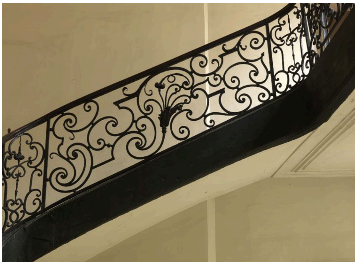
Escalier principal : le dernier panneau rampant.
