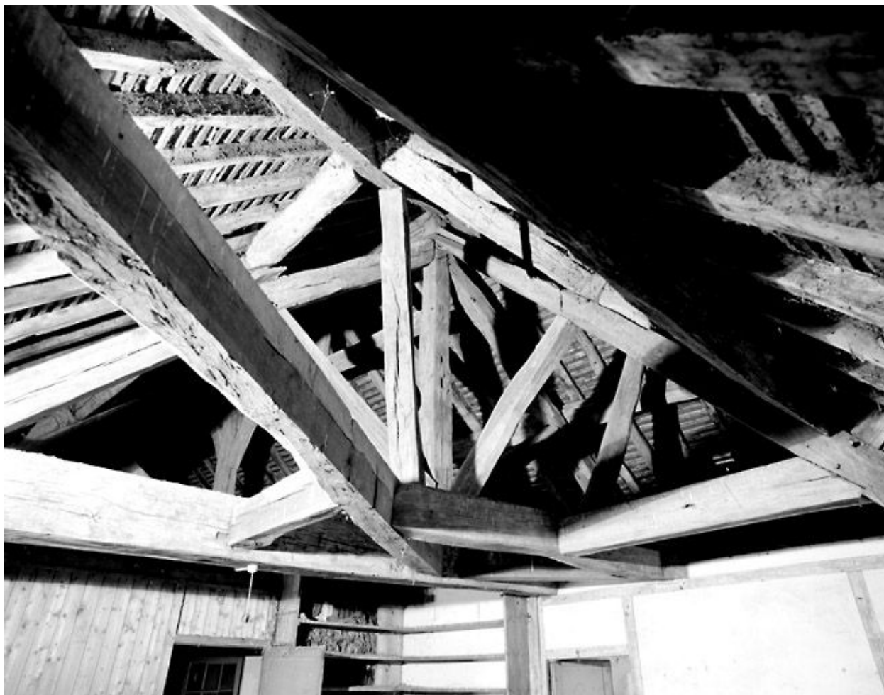
Vue de la charpente, à l'angle sud du corps de logis.
