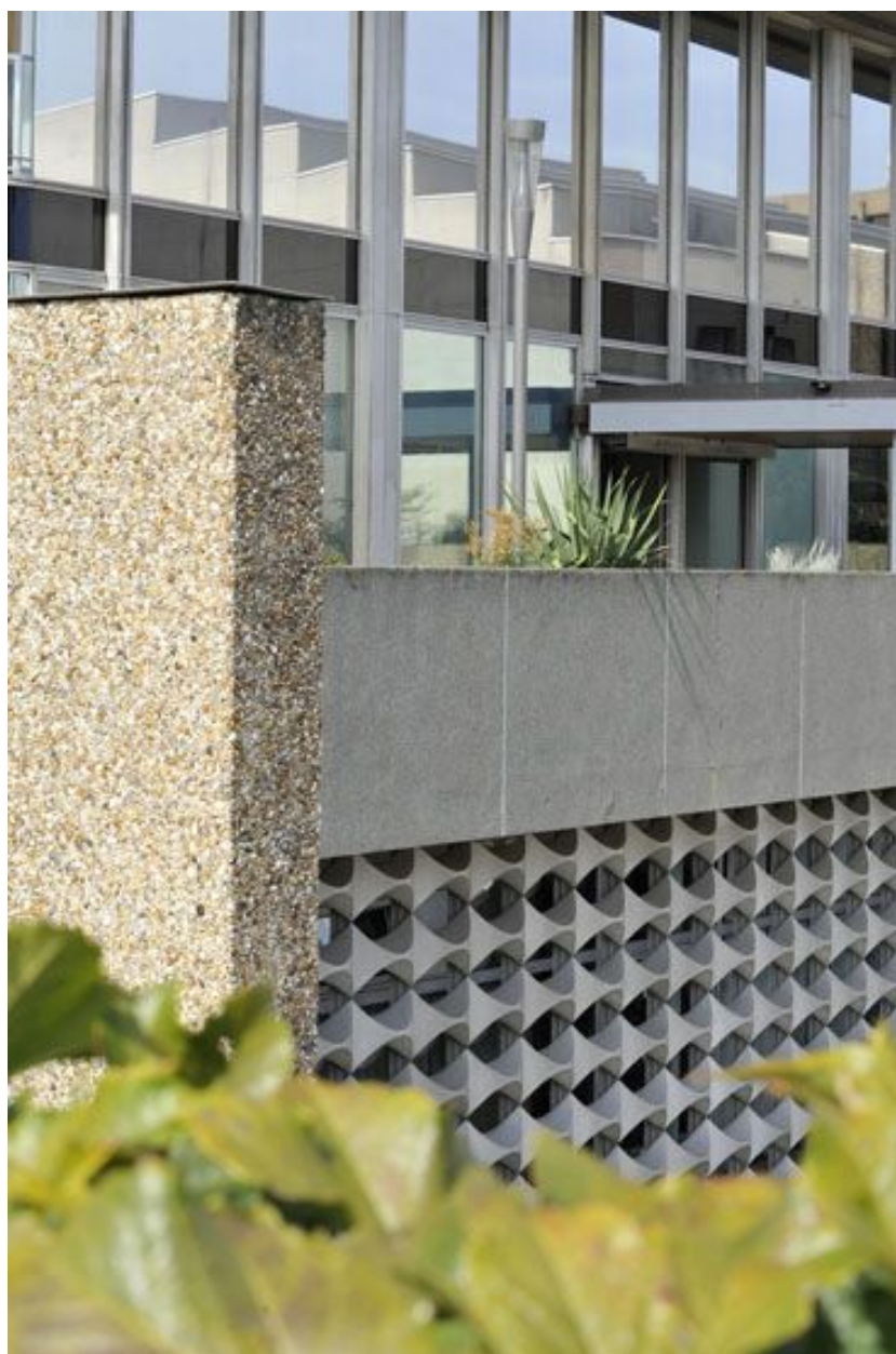
Détail des claustras de la partie inférieure du bâtiment, donnant sur le parking.
