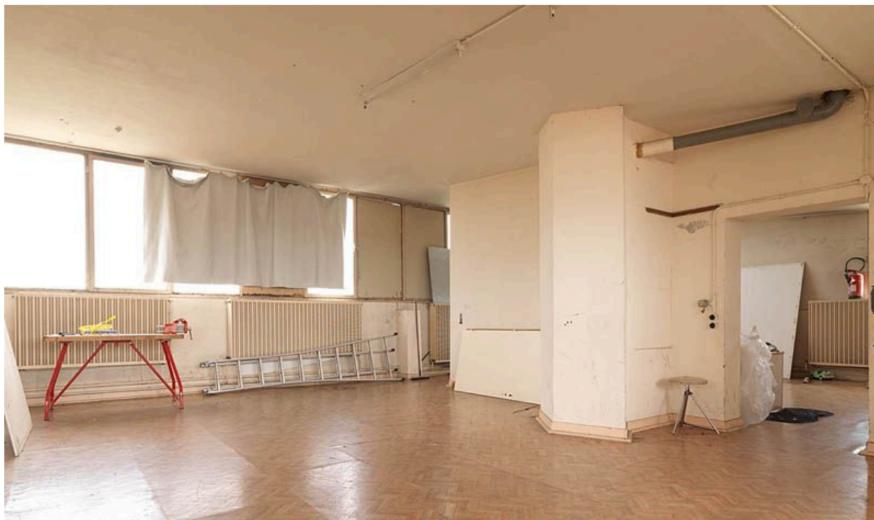
L'immeuble prototype. Vue intérieure des anciens séchoirs.
