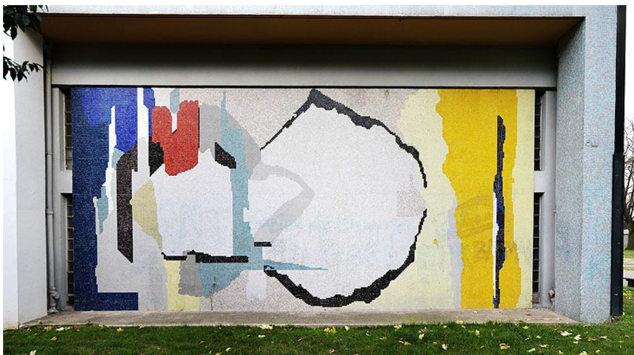
Chevilly-Larue, grand ensemble dit le Sorbier- La Saussaie, rue Paul Hochart rue du Rouergue rue Bretagne avenue Franklin Roosevelt rue du Nivernais. Détail du décor de céramique du soubassement de la tour.
