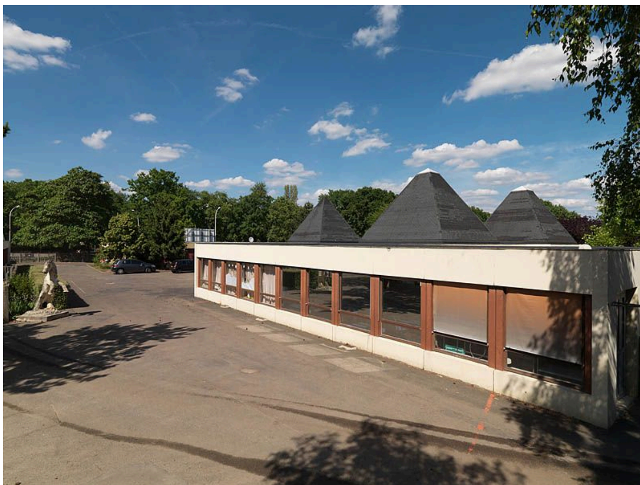
cité dite Résidence Pergaud. Arrière de l'école.
