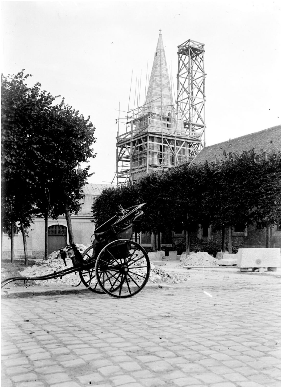
Le clocher échafaudé en 1900, depuis la place de l'église.
