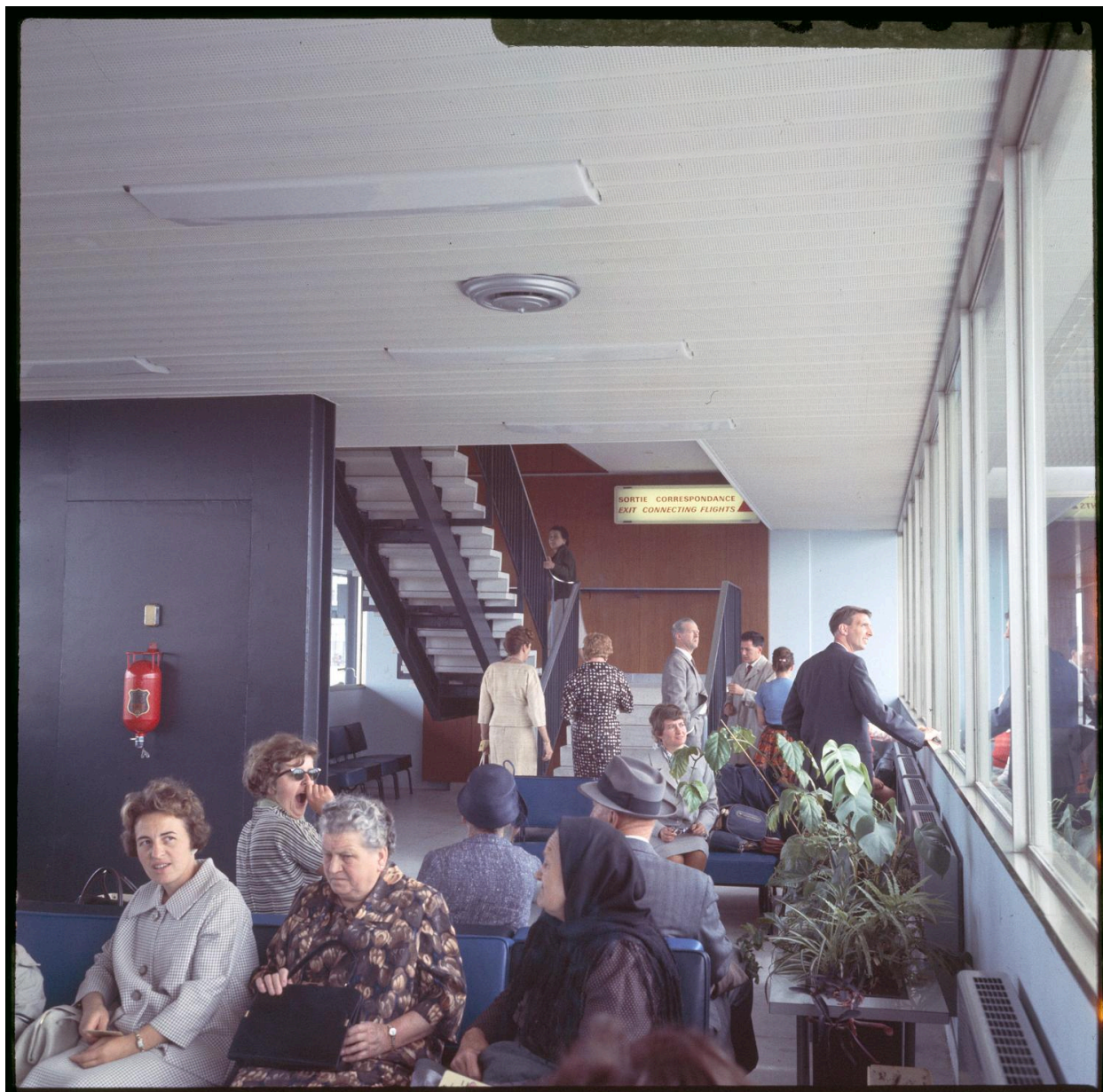
1961, salle d'embarquement, rez-de-chaussée coté piste.
