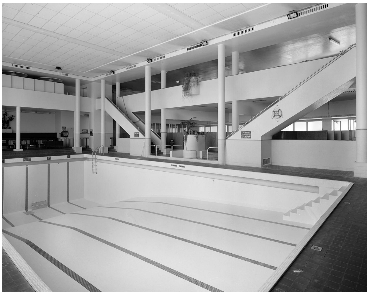
Piscine. Vue intérieure. Ecole maternelle, école primaire de garçons, école primaire de filles dites groupe scolaire Marius Jacotot
