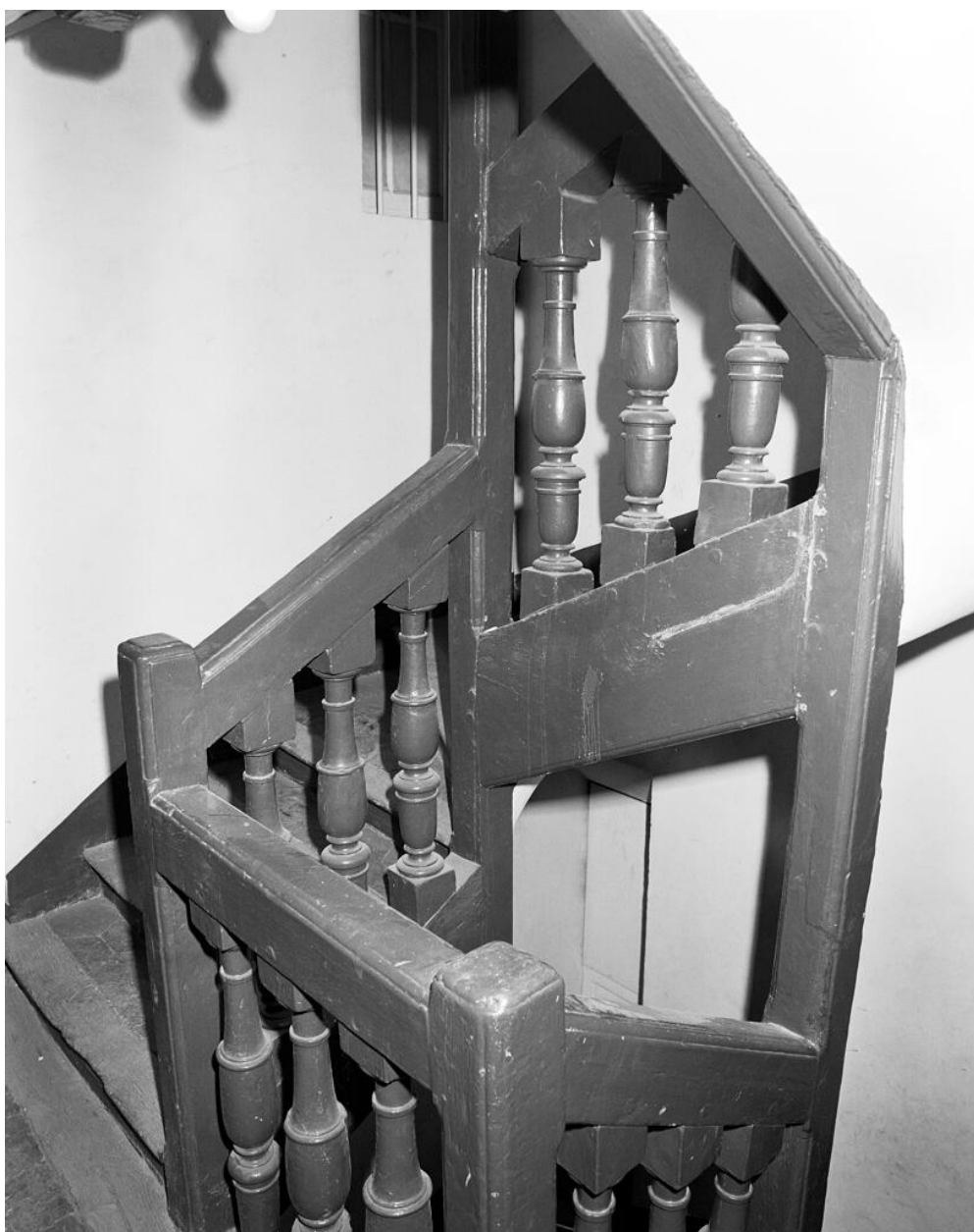
Entrée sud dite porte Pétrous. Pavillon, 56, avenue de Paris, vue de l'escalier à quatre noyaux.
