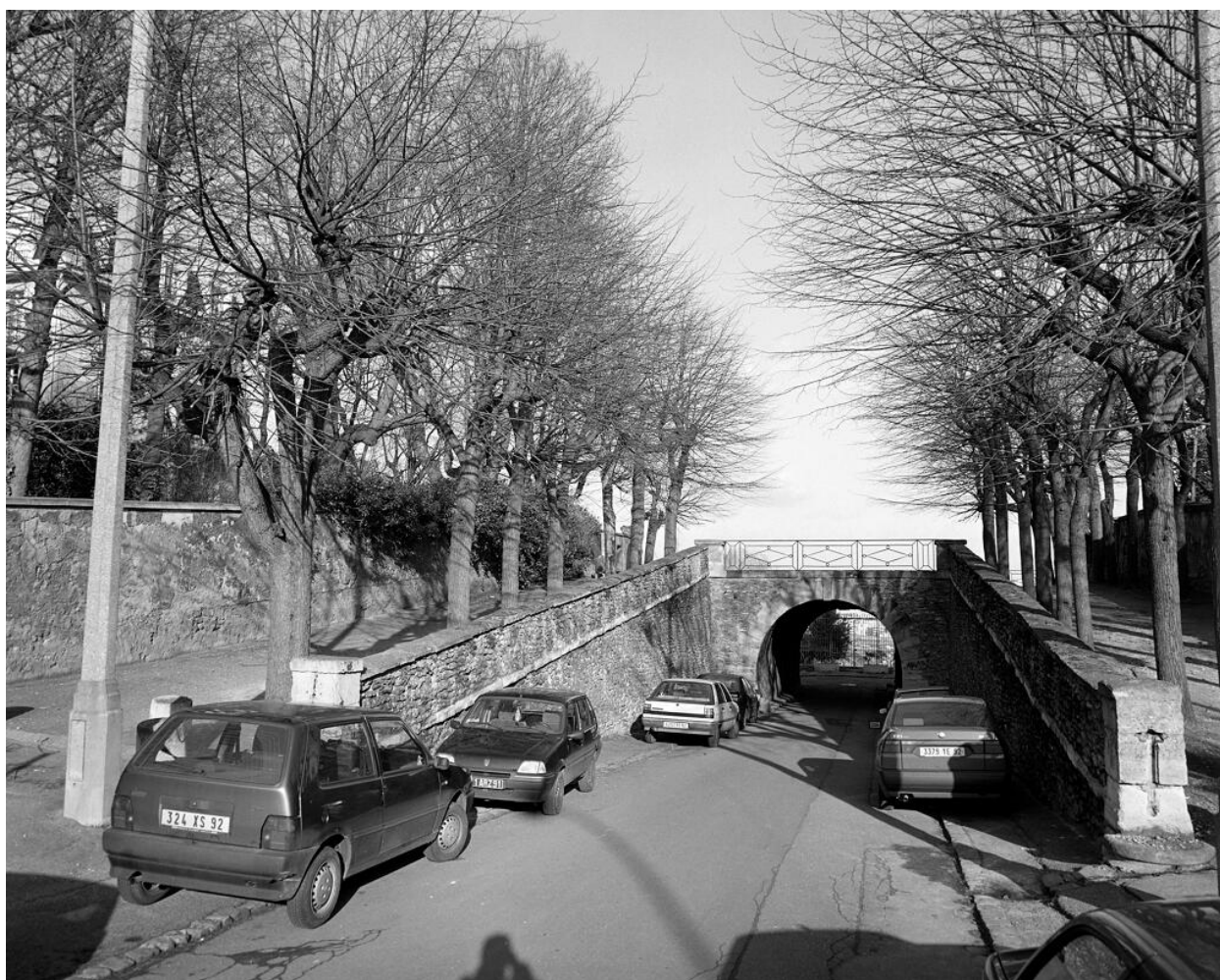
Accès à la rue basse de la terrasse.
