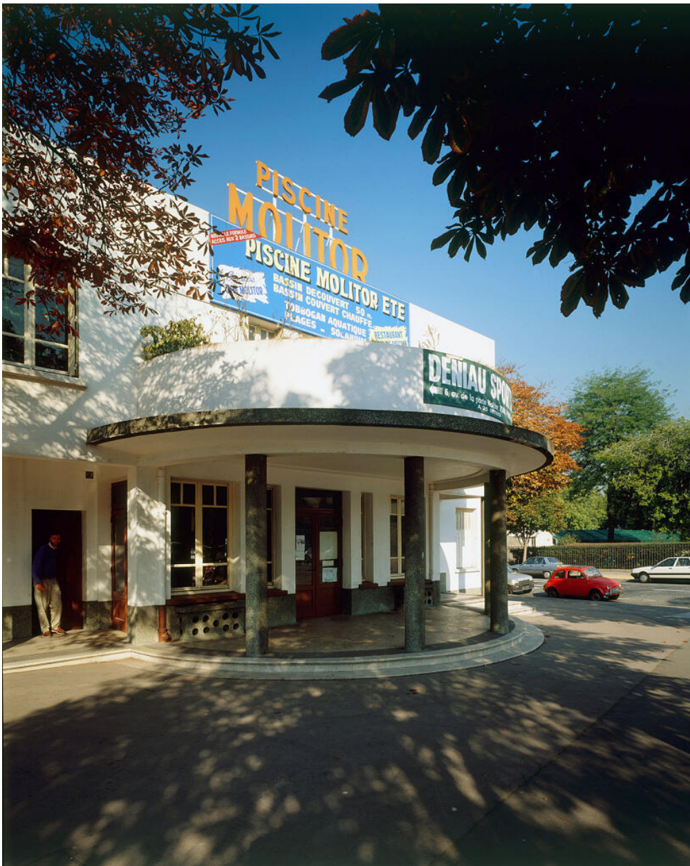
Entrée du bassin d'hiver, place de la Porte Molitor. Piscine Molitor
