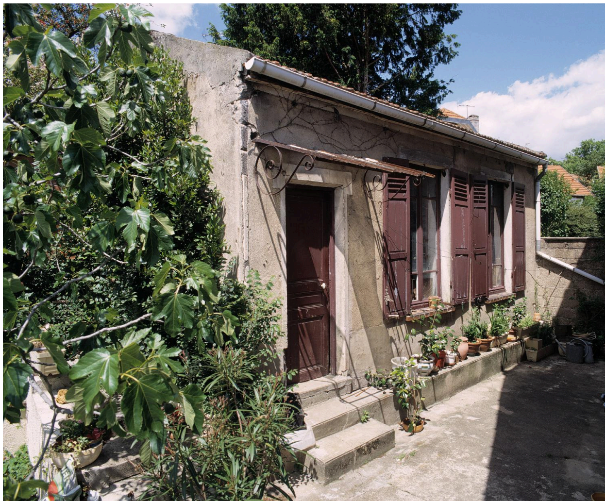
Vue d'ensemble du cabanon situé au fond de la parcelle.
