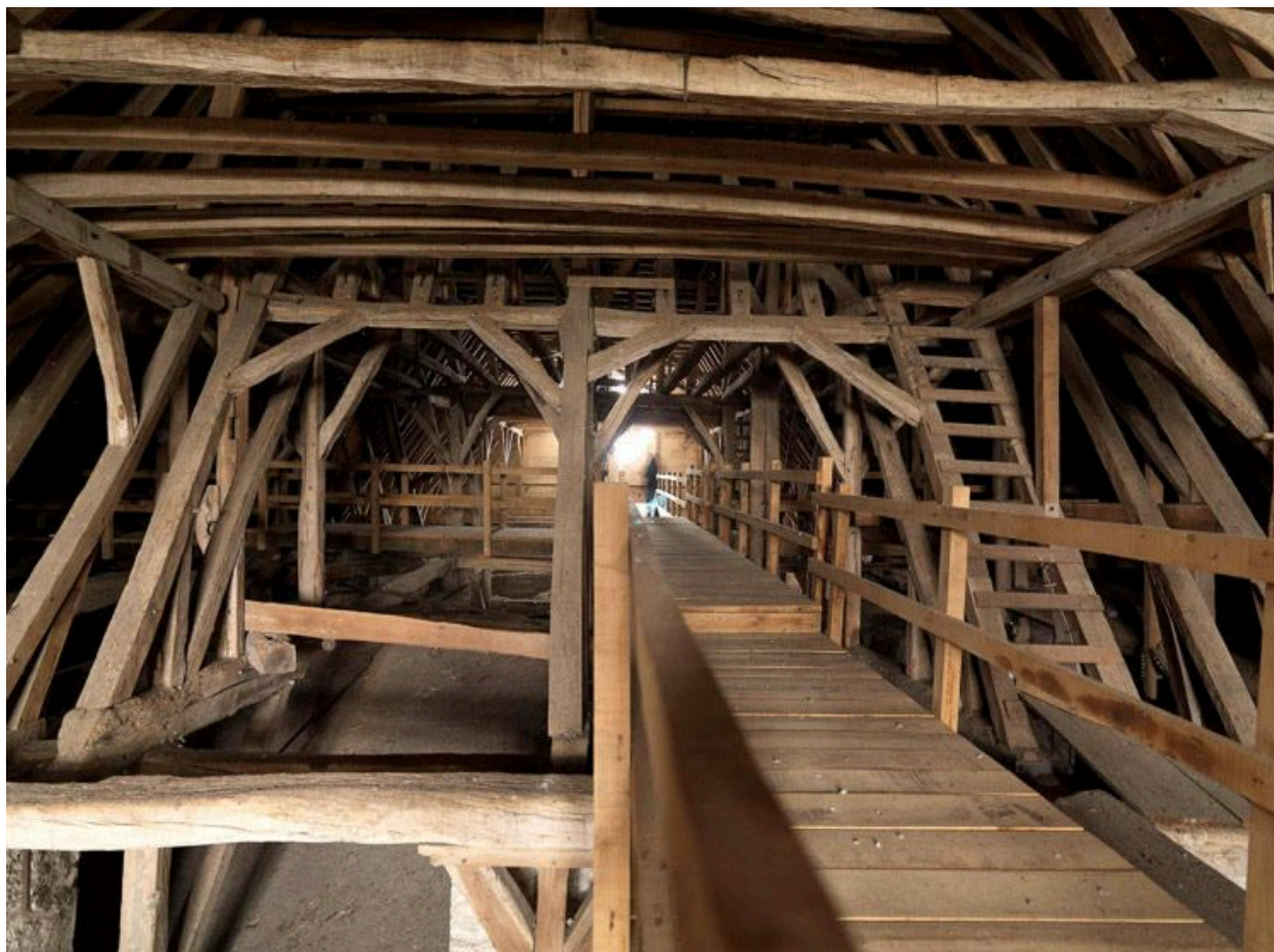
La charpente du transept : vue d'ensemble, du nord vers le sud.
