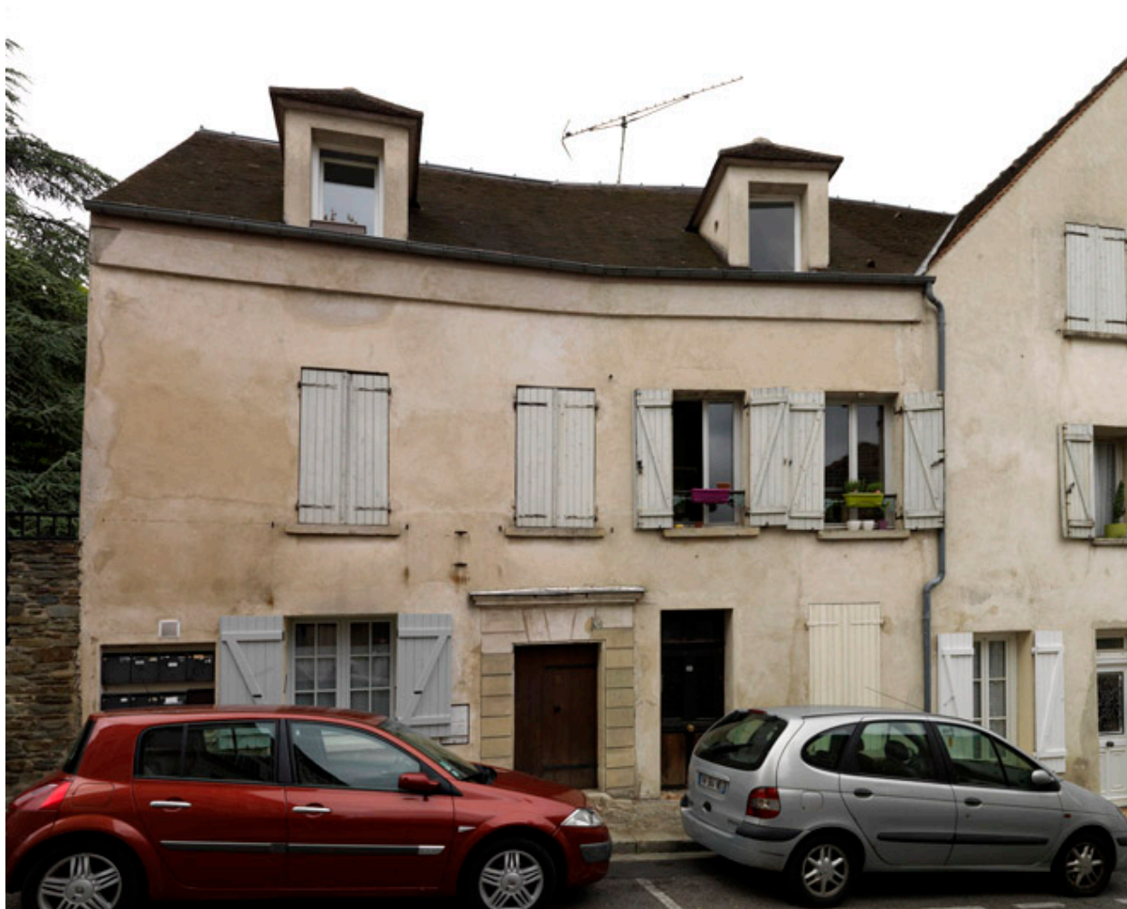
Maison de bourg, 10 rue de la Sangle. Vue d'ensemble.
