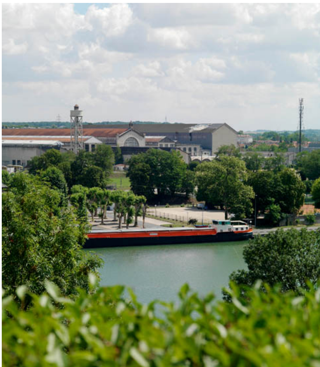
Vue générale de l'usine depuis la Seine. Le château d'eau, la nef centrale et son clocheton et le grand hall.
