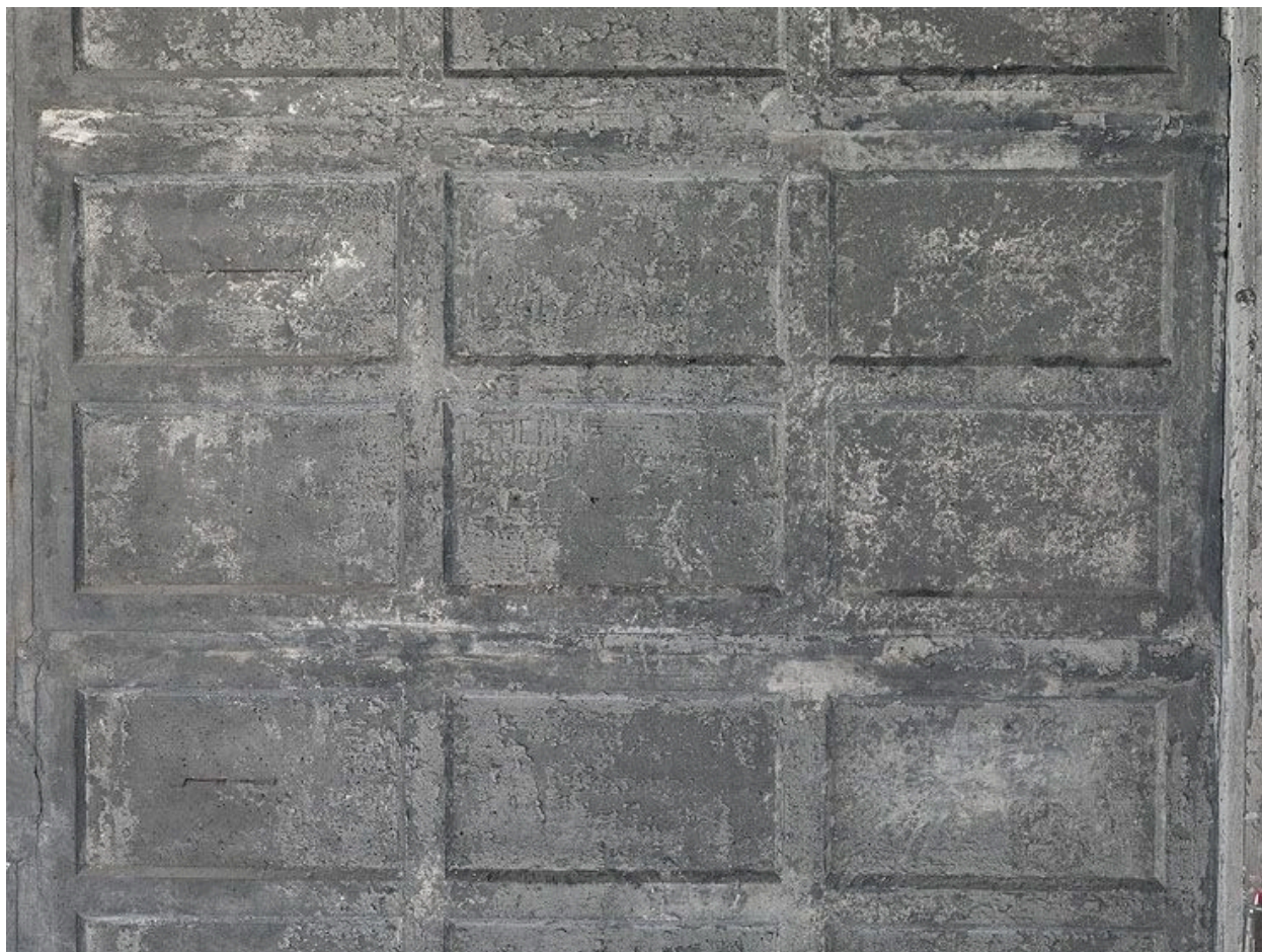
Vue large sur les modules de béton vibré et moulé constituant les éléments de façade.
