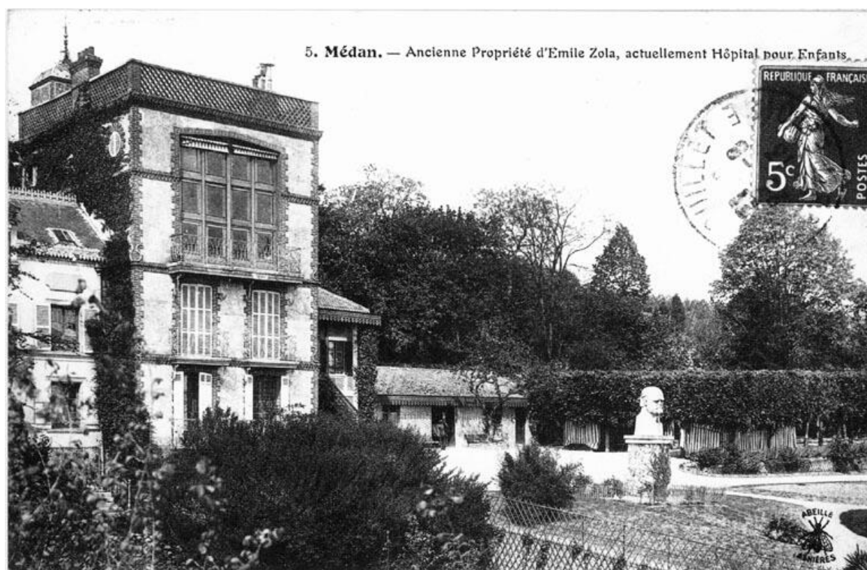
Vue de l'aile nord et d'une partie du jardin. Carte postale, La Source.
