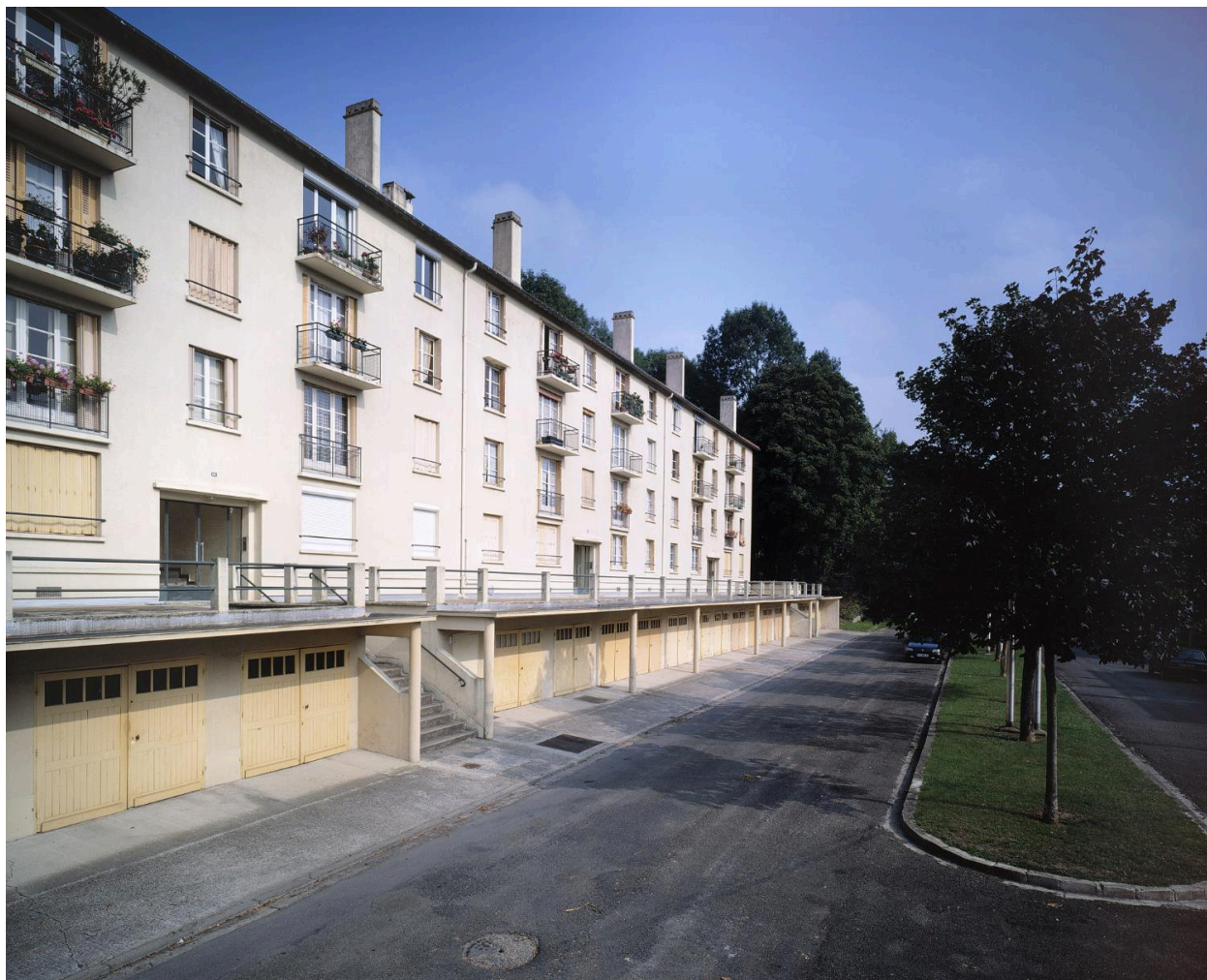
L'immeuble n° 65-69 en bordure de la boucle qui termine la rue.
