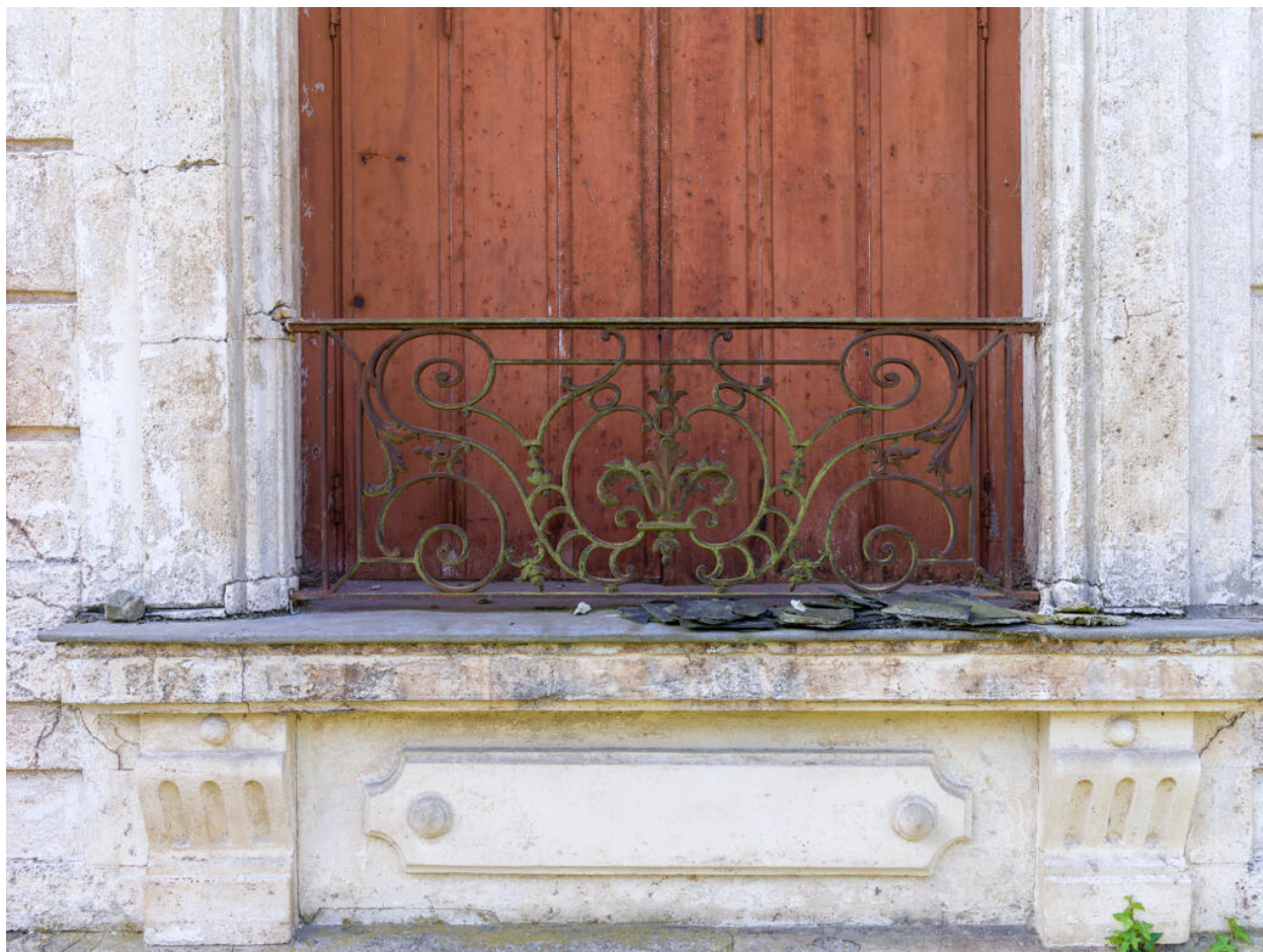
Détail de la partie basse de la baie ouest du rez-de-chaussée de la façade nord.
