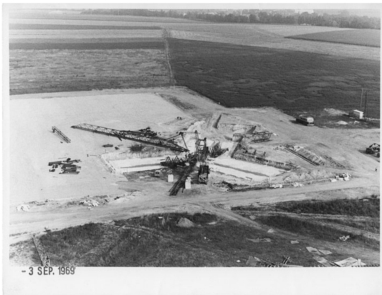
Début du chantier de construction d'une des tours de Meaux-Beauval. Montage de la grue dans le noyau. 3 septembre 1969. (OPAC Meaux)
