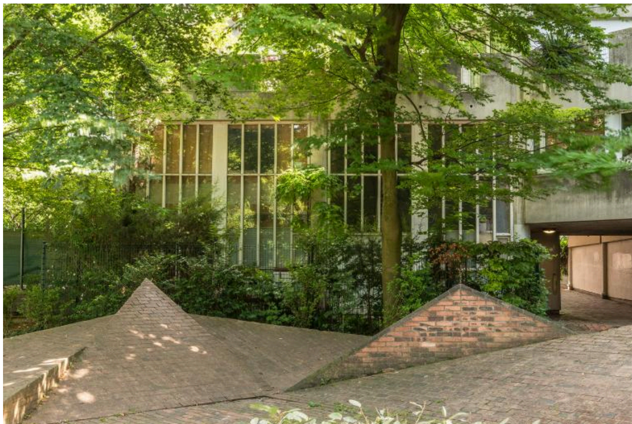
Ateliers en rez-de-chaussée, allée Henri Matisse
