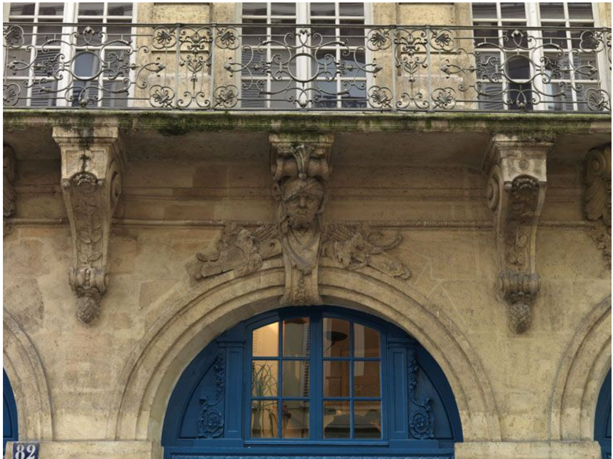
Détail des consoles du balcon.
