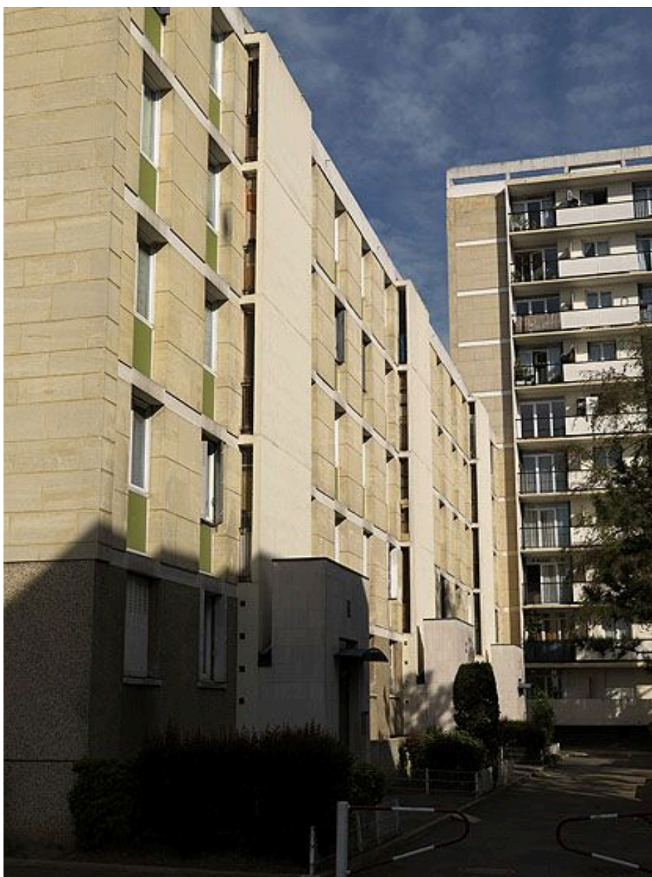
Vitry-sur-Seine, cité dite cité Gagnée, rue Gagnée, rue Champollion, rue de la Fraternité. Détail de la façade.
