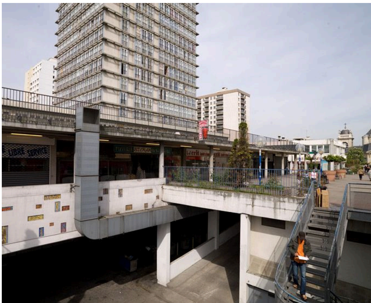
Choisy-le-Roi, secteur urbain concerté dit dalle du centre-ville. La dalle.
