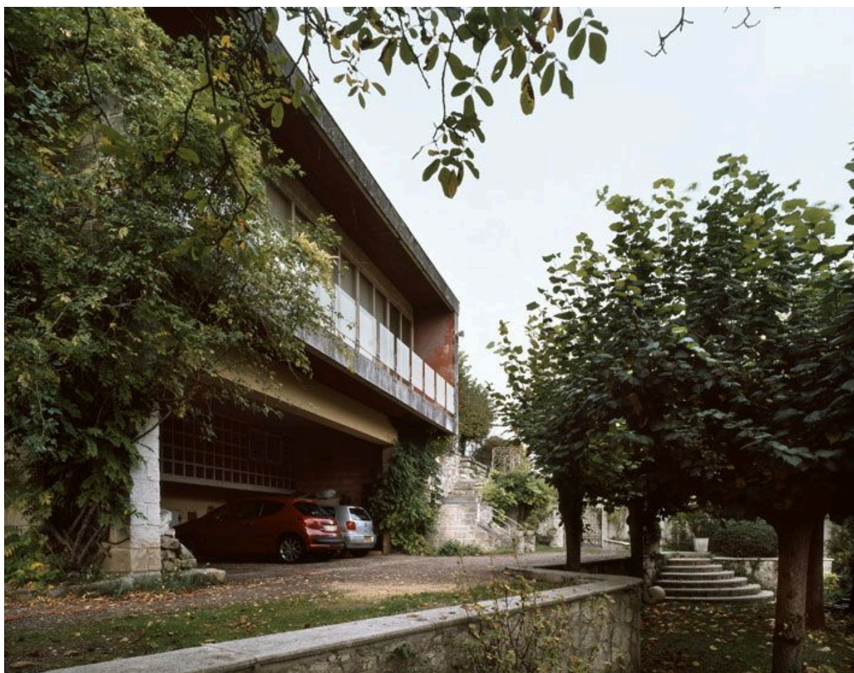
Vue de la façade panoramique.
