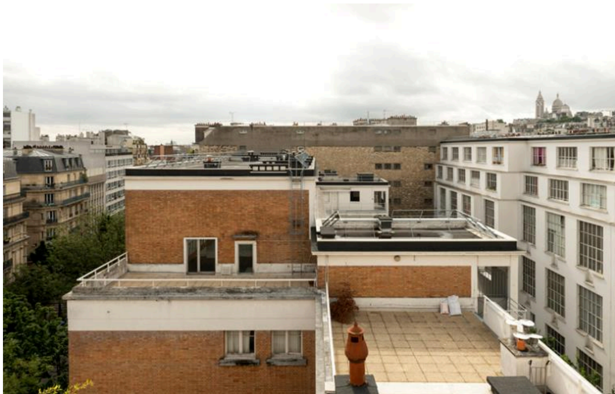
Toit terrasse du bâtiment A
