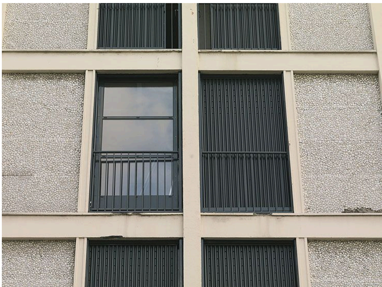
Détail de la façade après travaux.
