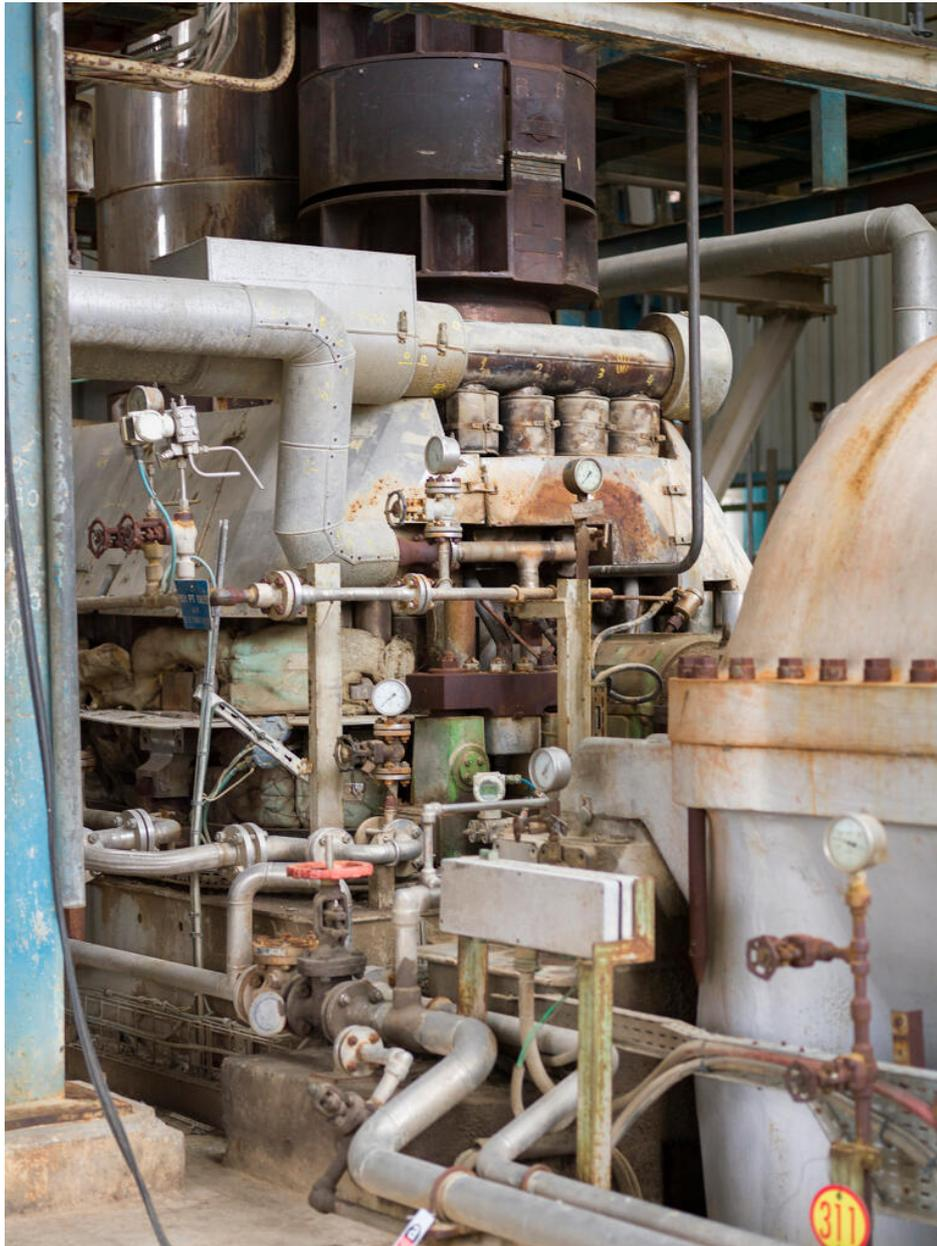
Unités Est - Zone FCC (Unité 651). Compresseur turbo-alternateur, autrement dit compresseur à récupération d'énergie. Vue de la turbine de récupération d'énergie, à gauche.
