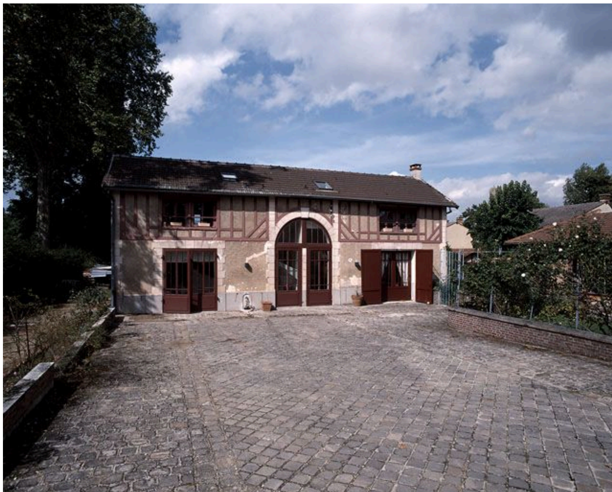
Les communs : façade sud du bâtiment situé au fond de la cour pavée.
