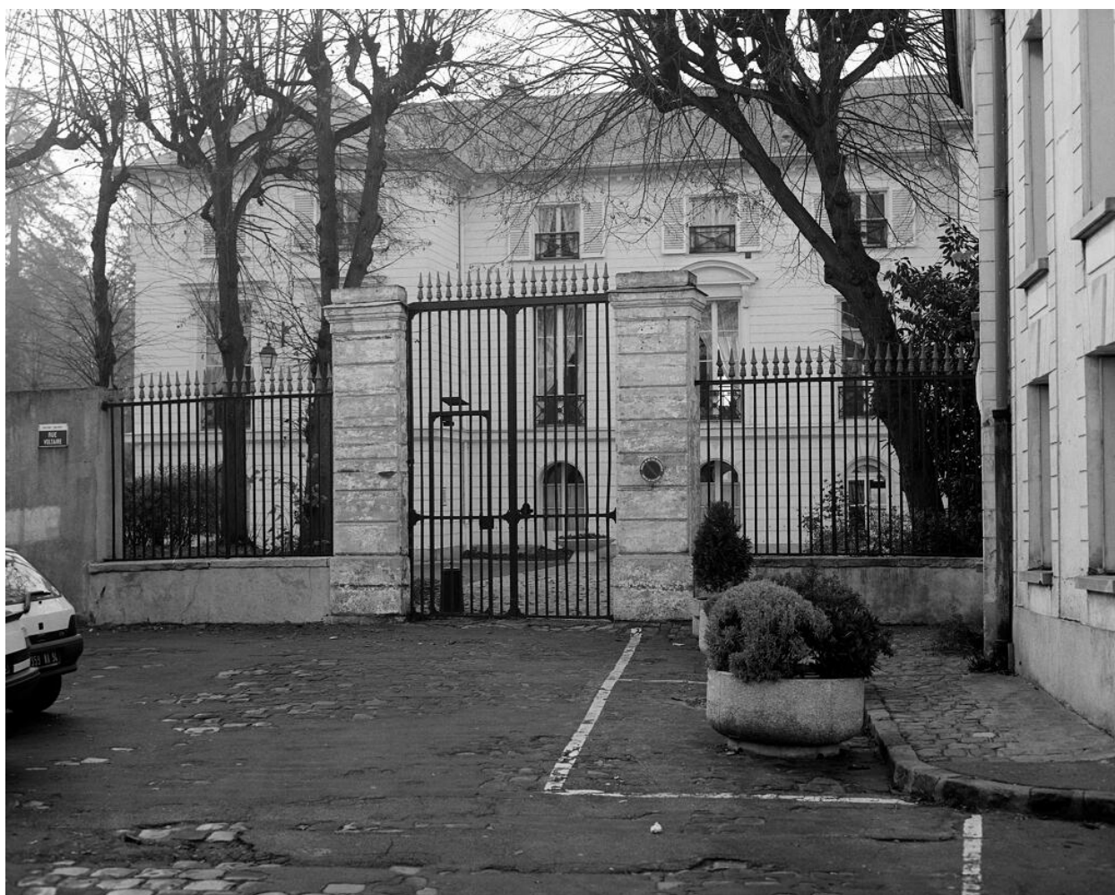
Le portail et la grille de cloture côté rue.
