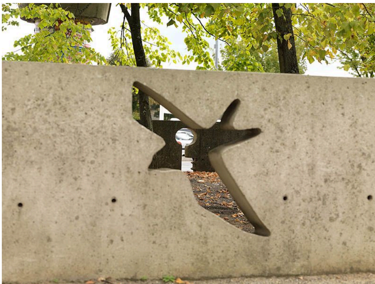
Détail d'un mur de béton figurant un oiseau au 19 rue de la Grande Borne.
