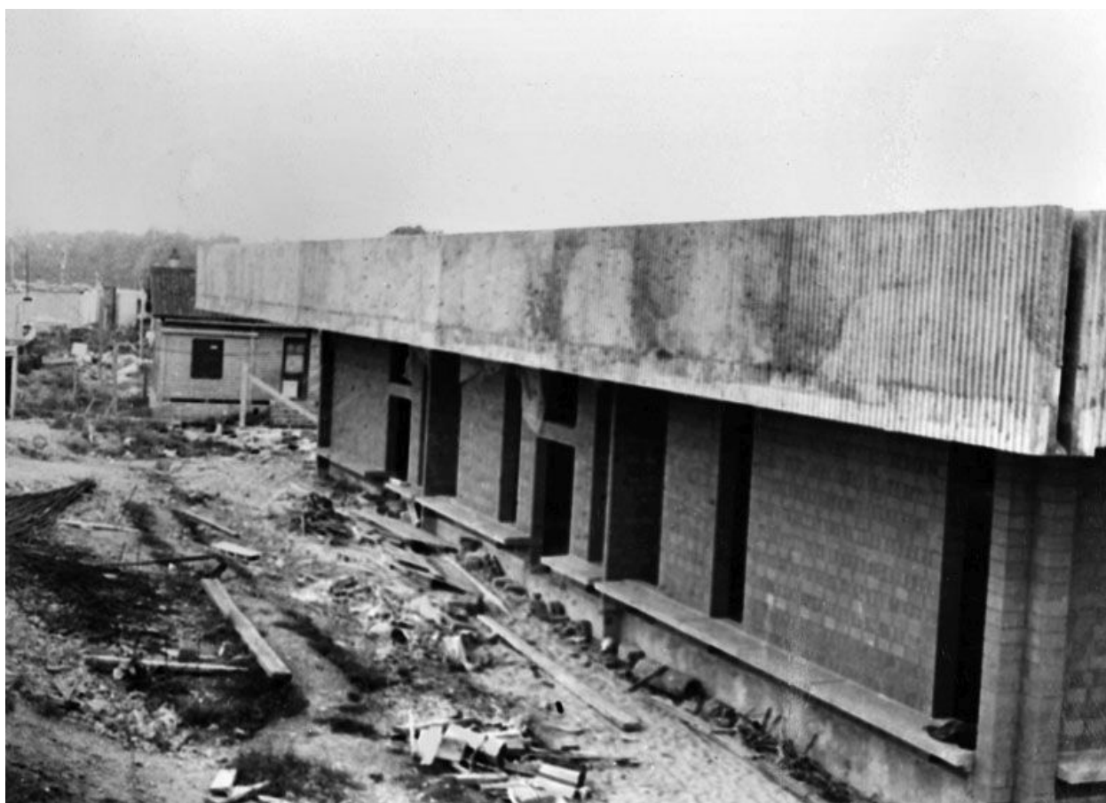
Façade sud lors du chantier de construction. Photographie ancienne, circa 1968. (Collection particulière)
