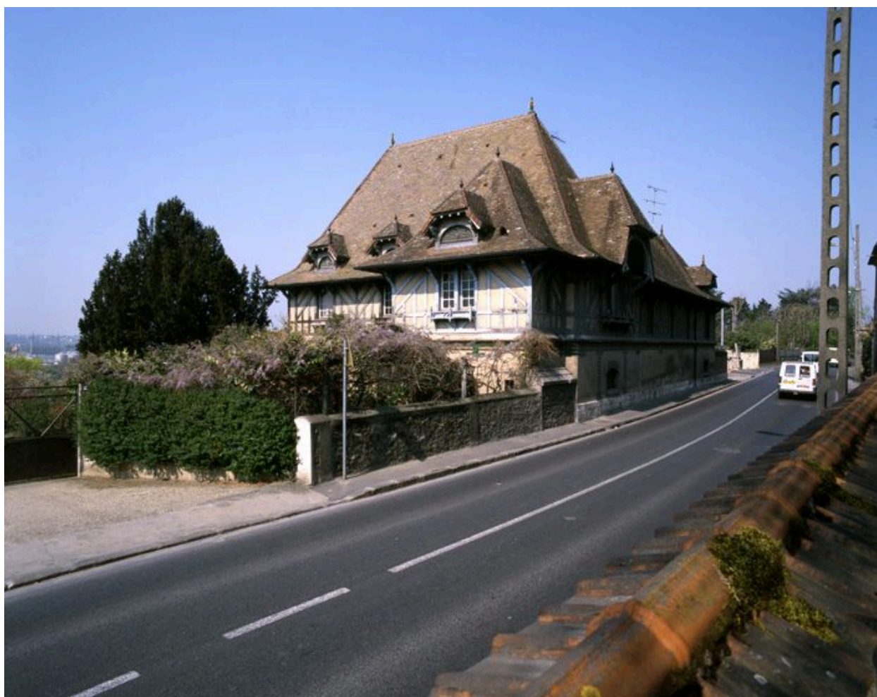
Vue d'ensemble de la laiterie située en face de la maison principale.
