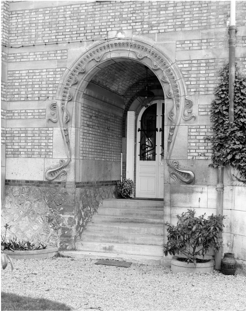
Façade latérale, entrée.
