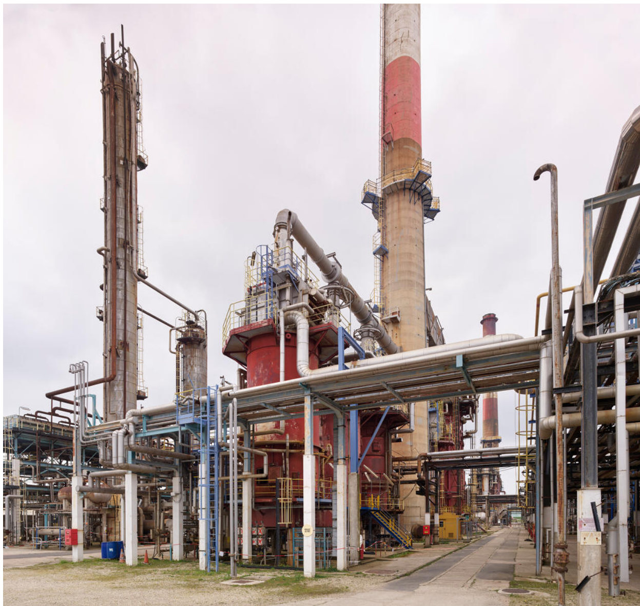
Unités Ouest. Vue sur l'allée des fours des unités catalytiques, depuis les abords de la salle de contrôle.
